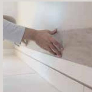
Para cortar la placa, marque con un lápiz la línea de corte. Coloque sobre la línea una escuadra o regla metálica y pase suavemente la trincheta sobre la marca unas tres veces. Fragmente la placa apoyando una parte sobre una mesa, alinee la marca de la trincheta con el borde y presione hacia abajo la parte que quedó en el aire. Si se mancha alguna placa con el adhesivo, remover pasando un trapo con alcohol común **LO ANTES POSIBLE**, una vez seco será **IMPOSIBLE REMOVERLO**.
